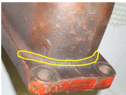
ΣΧΗΜΑ 3. Η ρωγμή όπως φαίνεται από την εξωτερική επιφάνεια
